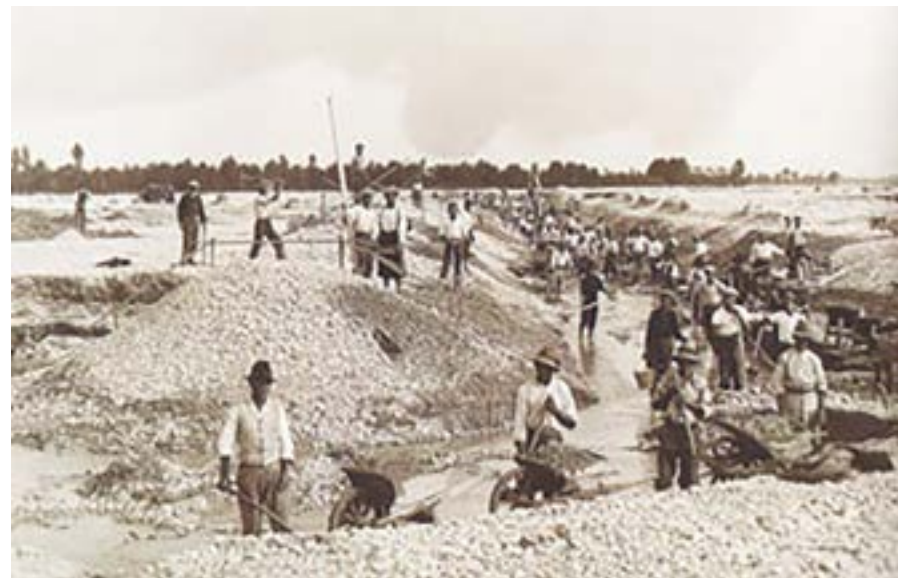
Bonifica del Basso Piave, lavori di arginatura
