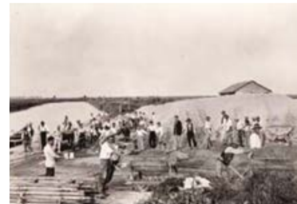
Cantiere di bonifica del Bacino Franzona
